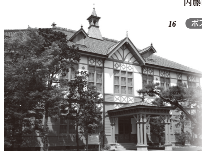
奈良女子大学記念館 明治42年に奈良女子大学の前身である奈良女子高等師範学校(現)の本館として建てられた建物で、木造総2階建ての寄棟造り。守衛室(附 正門)とともに国の重要文化財に指定されている。(写真は奈良女子大学ホームページより)
