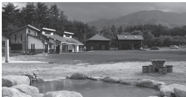
「あおぞら共和国」。広々とした敷地内に5棟のロッジのほか、交流棟、野外ステージなどがゆったりと配されている
